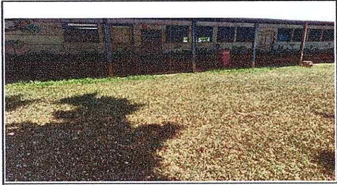
Foto1: Razón de cambio: Sustitución de la pared de madera por Blocks. En la parte en frente. Lado sur
