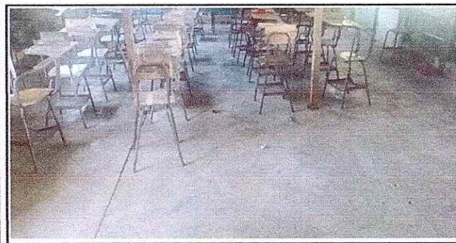
Foto 5: Razón de cambio: El piso fue hecha de arena blanca, se cambiara por piso hechas de arena de fundición.
