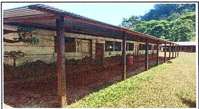
Foto 4: Razón de Cambio: Sustitucion de los horcones de madera por Concreto y colocación de piso. En la parte en frente
