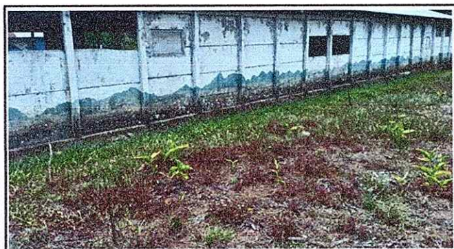
Foto 3: Razón de cambio: Sustitución de la pared de madera por Blocks. Lado Norte
