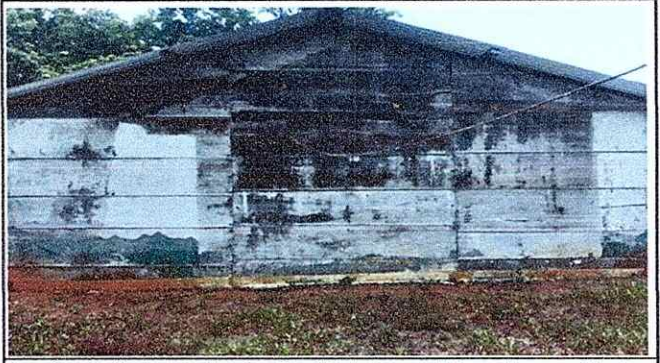
Foto 2: Razón de cambio: Sustitución de la pared de madera por Blocks.
